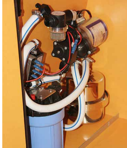
▲ Saubere Sache: Die Wasserversorgung ist mit einem Aktivkohle- und Seagull-Filter ausgestattet.
