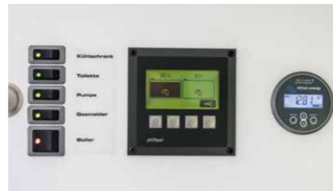
Alles unter Kontrolle: Die Schalttafel organisiert alle Funktionen des Wasserversystems und der verfügbaren Pumpen.
